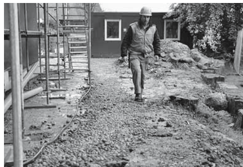
Bild 4: Dank des Magerbetons ist dieser temporäre Weg bei allen Wetterbedingungen sicher begehbar.
